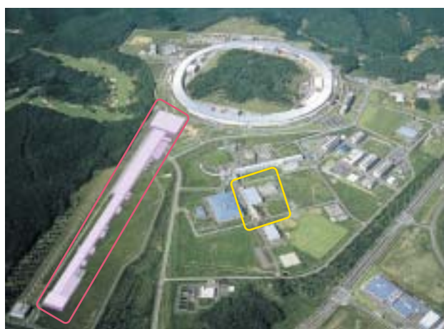
XFEL施設建設予定地
