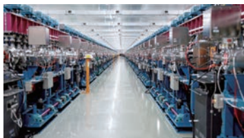
SACLA内部 真空封止アンジュレータ
