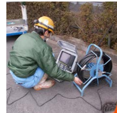
漏水検査作業の様子
