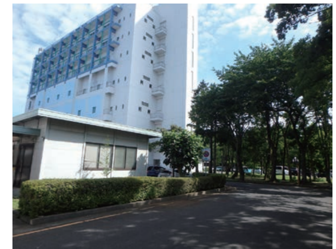
バイオリソース棟付近の中高木管理状況
